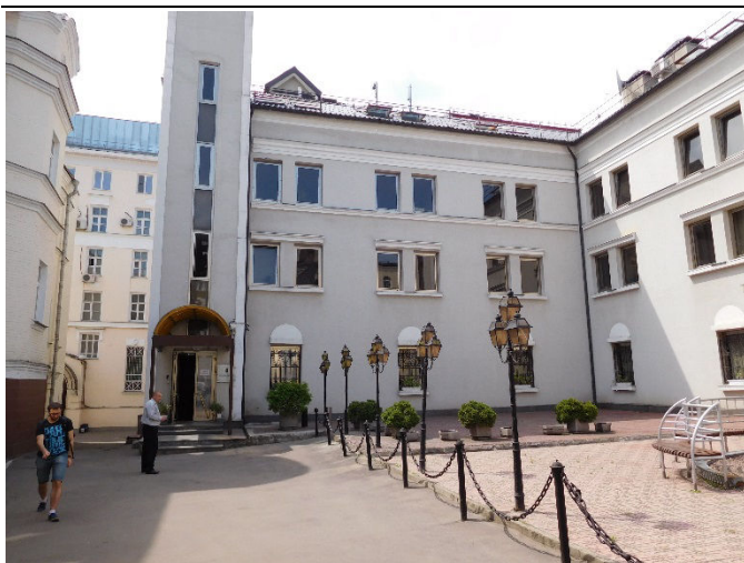
Фотография 3.1. Внешний вид здания
